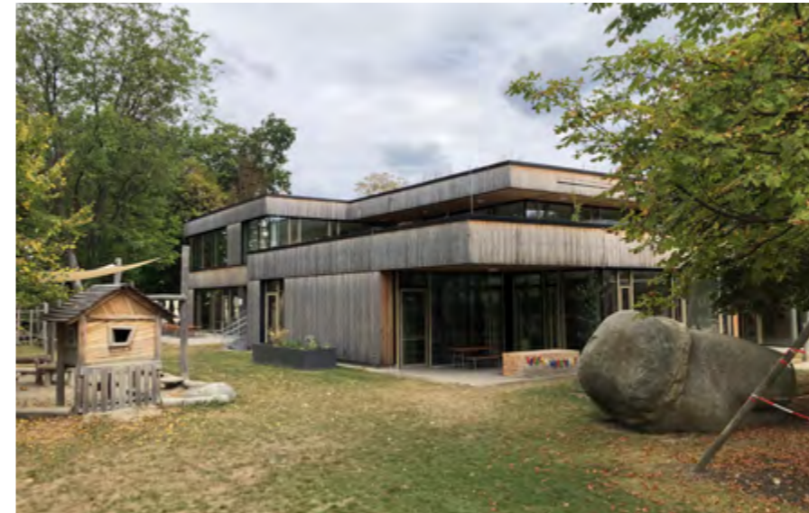
Sport ist Trumpf. Die großzügige Sport-Kita in der Burghäuser Mozartstraße stellte das Bauunternehmen Grundner im Jahr 2017 fertig
