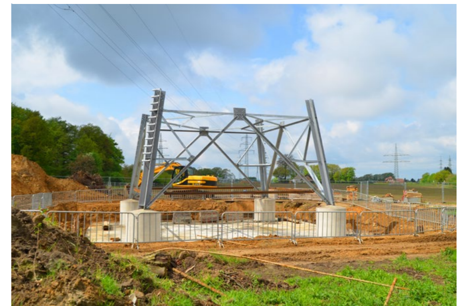
Noch ist ein wenig Zeit, doch wenn der Trassenverlauf für die 380-kv-Leitung und die Standorte für das geplante Umspannwerk und die Windräder feststehen, wird es viele Baustellen im Landkreis geben
