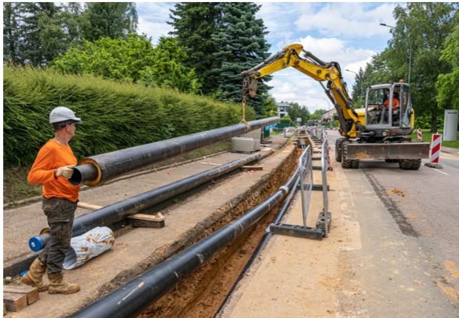
Sobald feststeht, dass sich genügend Haushalte für einen Umstieg auf Fernwärme entscheiden, können die Planungen für die Bauarbeiten beginnen. Dann rücken die Maschinen an, um die Leitungen zu verlegen
